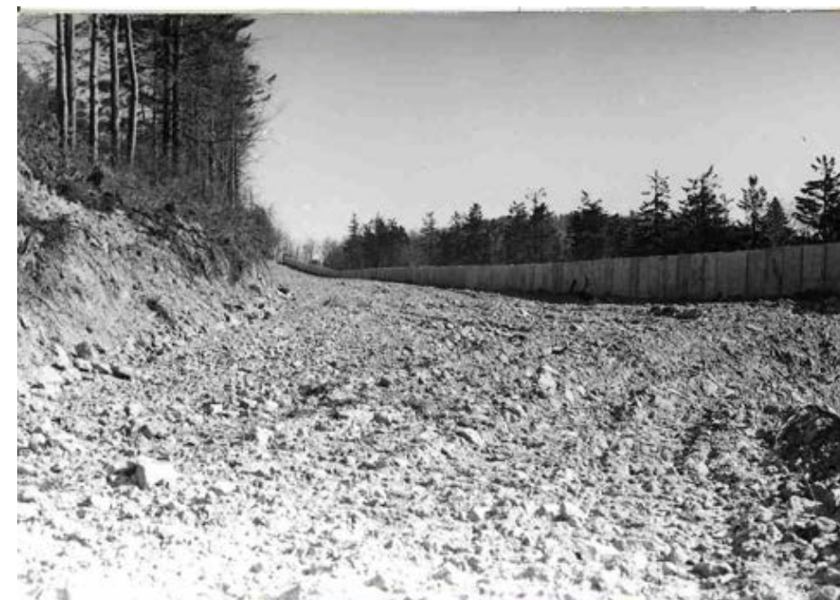
15. Výstavba parkoviště na Pustevnách (foto archiv obce)
