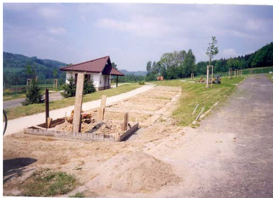
66. Stavba hřbitova – stavba betonových základů rámů hrobů (foto archiv obce)
