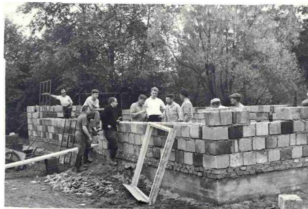
38. Stavba objektu SVAZARMU. Rok 1967 (foto archiv obce)
