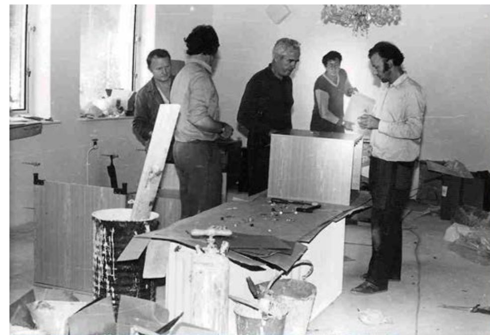
49. Rekonstrukce obecního úřadu rok 1984 (foto archiv obce)
