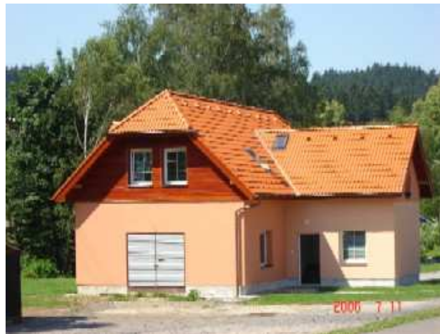
67. Bývalá budova SVAZARMU ve středu obce – rok 2006 (foto archiv obce)
