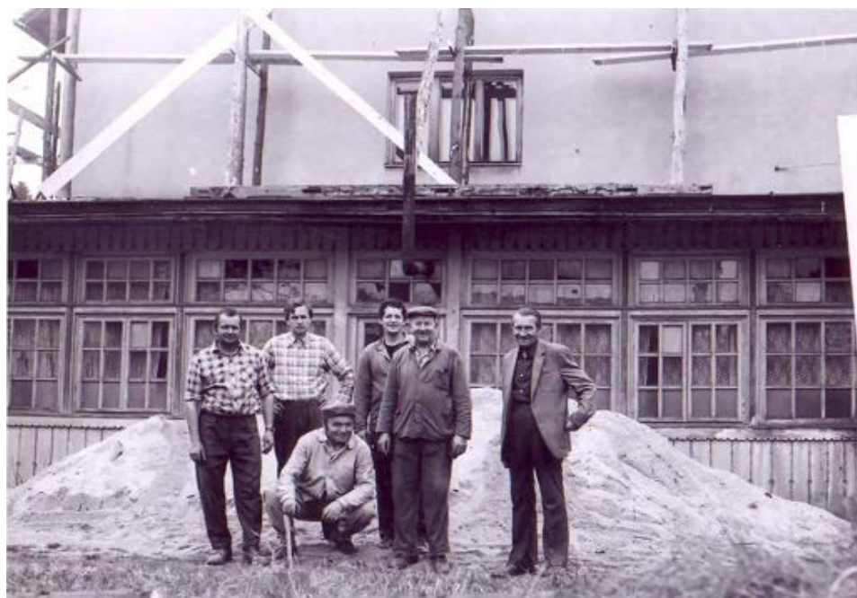
30. Oprava Hotelu Bečva (foto archiv obce)
