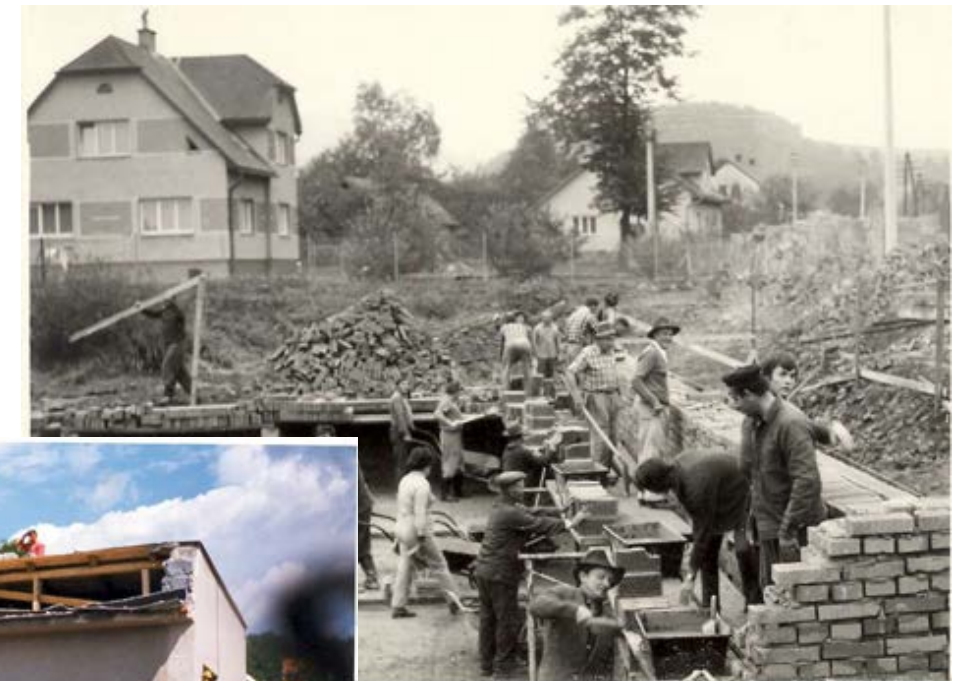
54. Rekonstrukce domu služeb (foto archiv obce)
