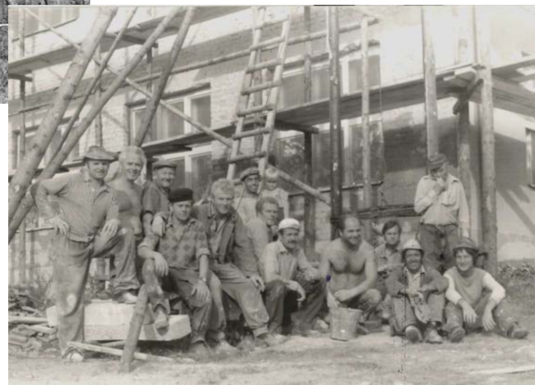
47. Oprava školy v Bacově – rok 1983 (foto zapůjčil pan Červený Metoděj)
